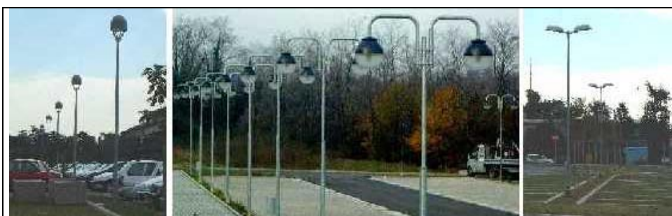
Fig.8 – Ai lati della foto due parcheggi conformi alla LR17/00 ed al centro uno realizzato con sfere in parte schermate comunque non conformi alla LR 17/00
