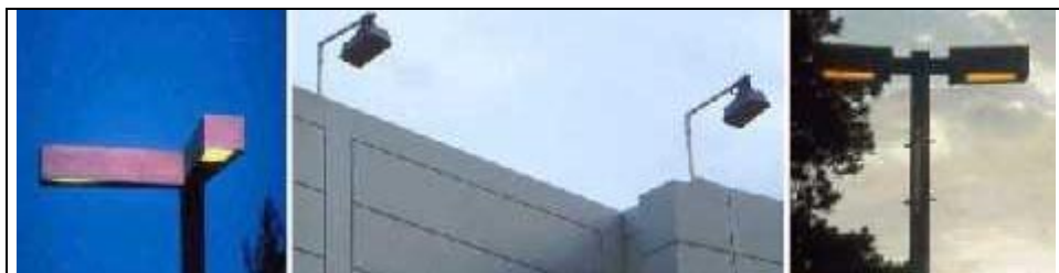
Fig.14 – Nelle foto sono evidenziati alcuni apparecchi per illuminazione stradale, di parcheggi e capannoni industriali. Le lampade utilizzate nelle tre foto sono al sodio BP completamente full cut-off a vetro piano orizzontale.
