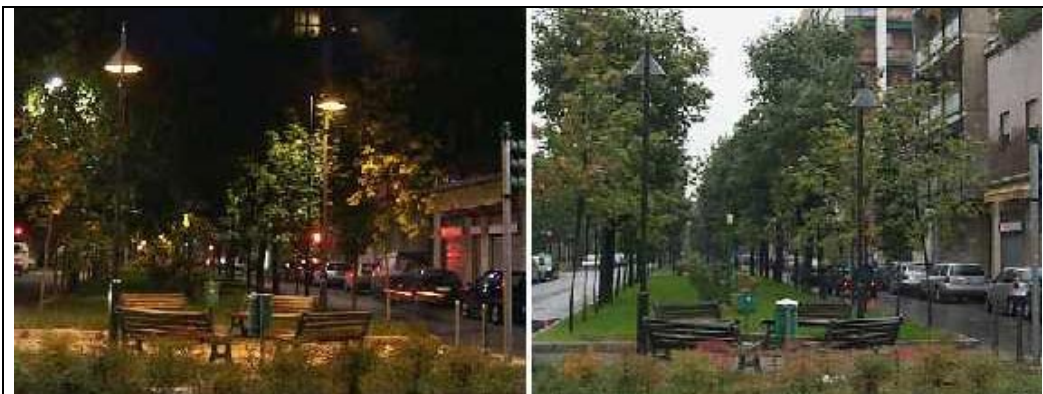
Fig.24 – Illuminazione (notturna e diurna) di aiuole e di giardini con impianto conforme alla LR17/00 e del relativo regolamento di attuazione.
