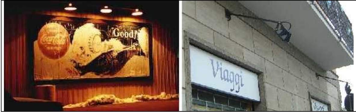
Fig.20 – Sulla destra un insegna di esercizio che ai fini della LR17/00 non necessita ne di progetto ne di autorizzazione del sindaco anche se deve comunque essere verificata la rispondenza alle prescrizioni tecniche (0cd/klm a 90° ed oltre). In questo caso l'inclinazione poco consona alla LR17/00 potrebbe comunque essere compensata dallo schermo naturale del terrazzo. Nella foto di sinistra altro tipo di insegna (conforme alla LR17/00 in quanto illuminata correttamente) che essendo maggiore di 6 metri quadrati richiede comunque progetto e autorizzazione del sindaco.
