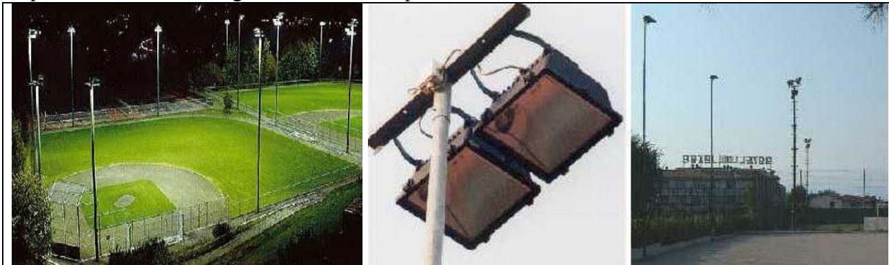
Fig.12 - Impianti sportivi illuminati in modo conforme alla L.R.17/00 con proiettori asimmetrici orientati orizzontalmente e che non disperdono luce verso l'alto.
