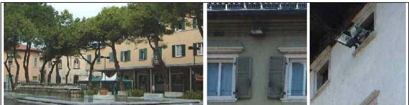
Fig.11 – (Nella foto di sinistra) Piazza del comune di Dalmine. Illuminazione conforme alla LR17/00 e sorgenti luminose poste in modo da non interferire con la chioma degli alberi. (Nell'immagine di destra) Due esempi di illuminazione di centri storici con apparecchi sotto gronda (nell'immagine più a destra un'apparecchio orizzontale affiancato ad uno inclinato e che invece disperde luce verso l'alto).
