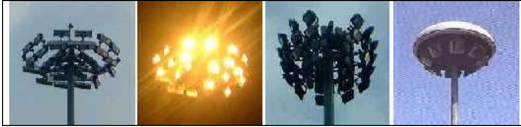
Fig.9 - Torri faro "palesemente" inquinanti. Nell'ultimo impianto a destra infatti, il cappello ha l'unico obiettivo di proteggere gli apparecchi d'illuminazione dalle intemperie.
